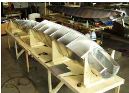
Construction d'un flotteur
